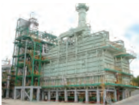
クライアント: スラブネフテ・ヤロスラブリ石油精製会社 設備名: 重質油熱分解(ビスプレーカー)設備 28,000 BPSD 建設サイト: ロシア ヤロスラブリ
