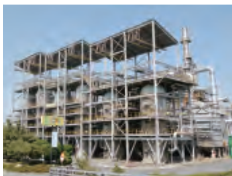
クライアント: エス・オイル 設備名: 減圧残渣油脱硫設備 57,000 BPSD 建設サイト: 韓国 ウルサン
