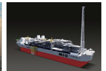
ブラジル沖 Raia FPSO
