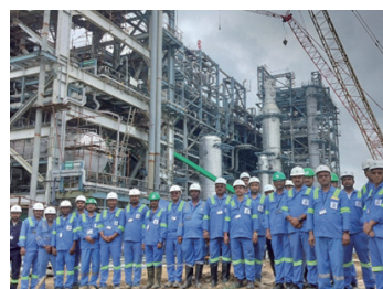
NRL社向け軽油水素化精製装置
