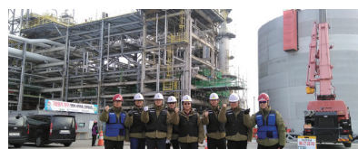
S-Oil社向け廃水処理施設
