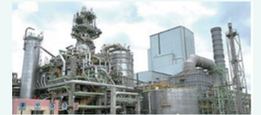
既設ACES21®肥料プラント
