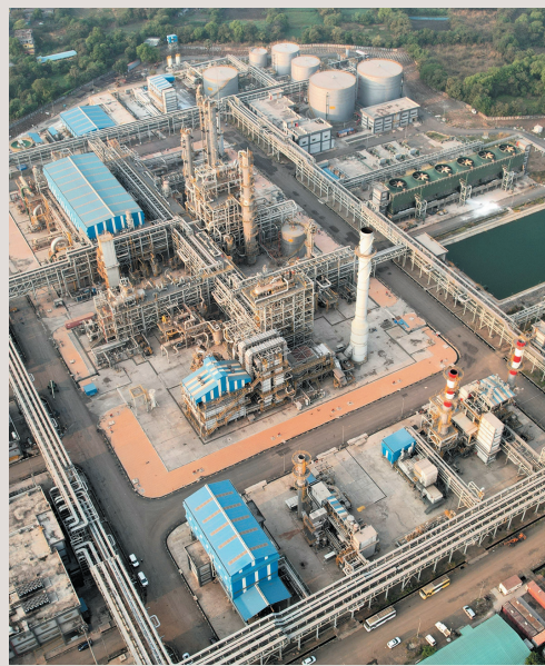
アンモニアプラント
