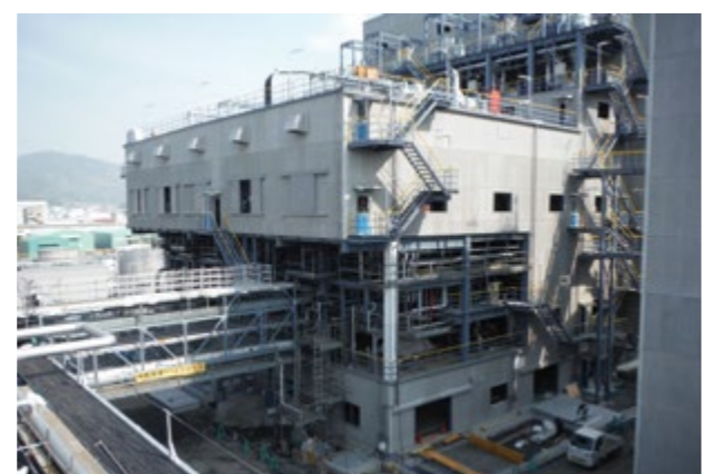
排ガス浄化触媒プラント
