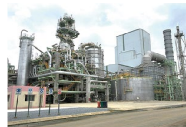
既設ACES21 ® 尿素プラント
