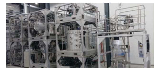
iFactory ® 実証設備
