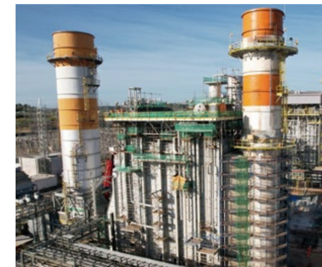
建設中のパルナイバ6ガス火力発電プラント
