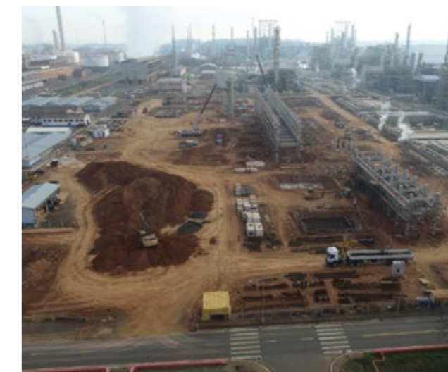
建設中のヘプラン製油所 ディーゼル脱硫・水素回収施設
