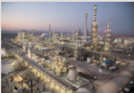
エチレン／ポリエチレン製造設備
