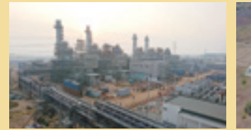
工事が先行する第2・第3件目(左)と、機器据え付け(右)の様子(2017年2月現在)
