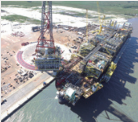
モジュールを船体に積み込む作業
