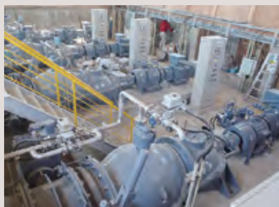
排水ポンプ増設（手前が増設4号機）
