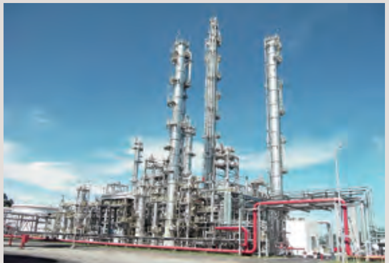
2013年に完成したブタジエンプラント
