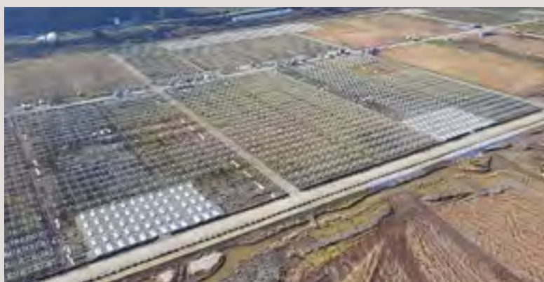
架台が設置されている建設現場
