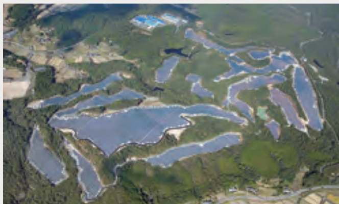
久米南メガソーラー全景
