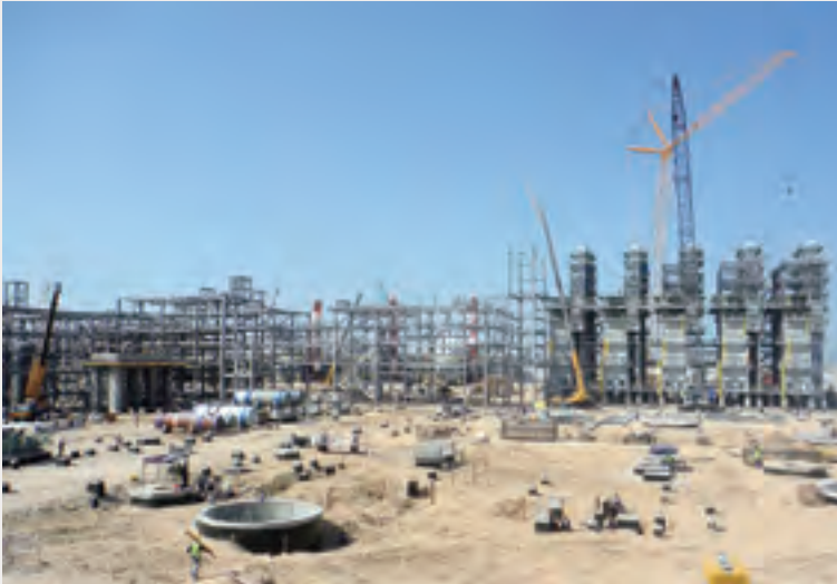
工事が始まったエタンクラッキングユニット
