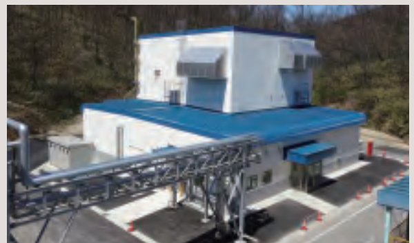
米沢浜理薬品工業第四工場 全景
