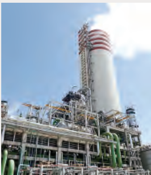
完成した肥料プラント
