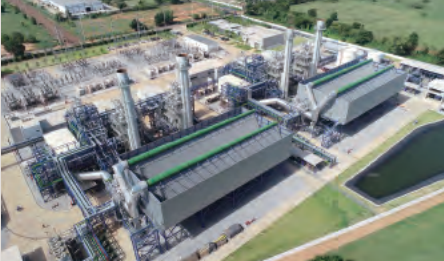
完成した発電プラント
