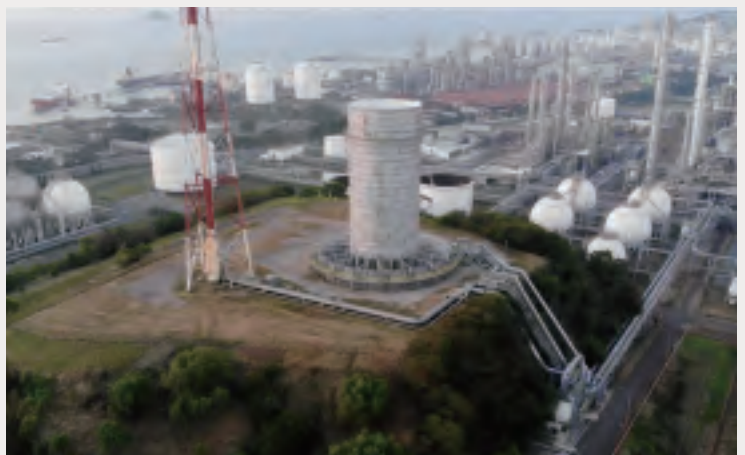
密閉式排ガス燃焼設備
