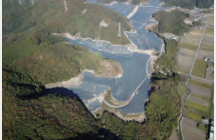
夢前メガソーラー発電所（兵庫県）
