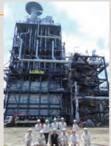
完成したナフサ分解炉とプロジェクトメンバー
