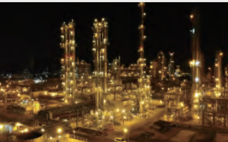
ブテン-1/MTBEプラント全景
