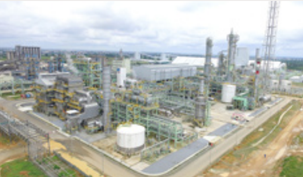
完成した肥料プラント
