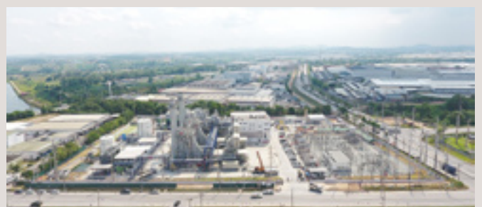
2017年5月 商業運転を開始した発電プラント
