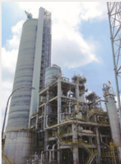
完成した肥料プラント
