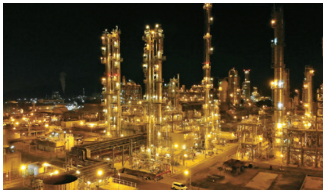
ブテン-1/MTBEプラント全景
