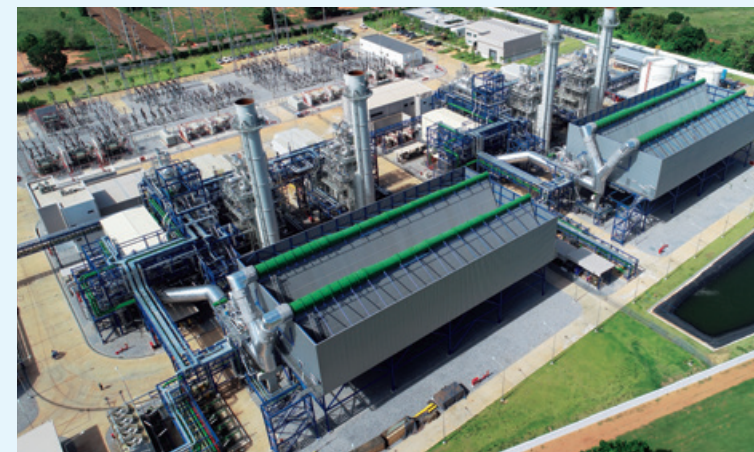
完工した発電プラント
