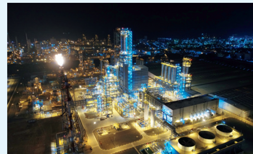
完工したポリエチレンプラントの夜景
