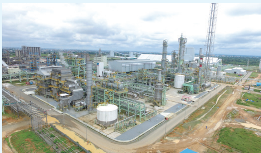
第1製造設備のプラント全景
