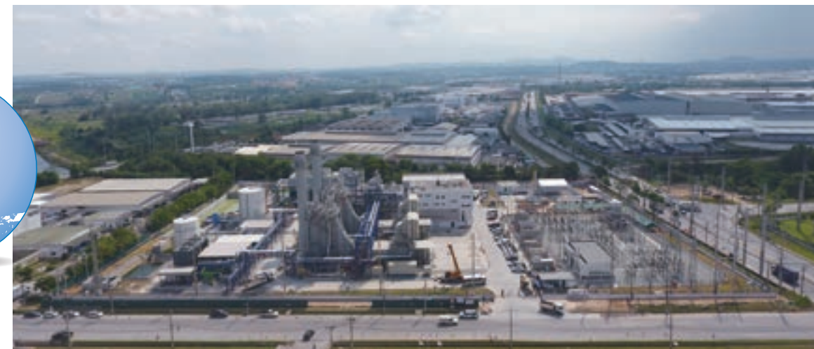
商業運転を開始した発電プラント
