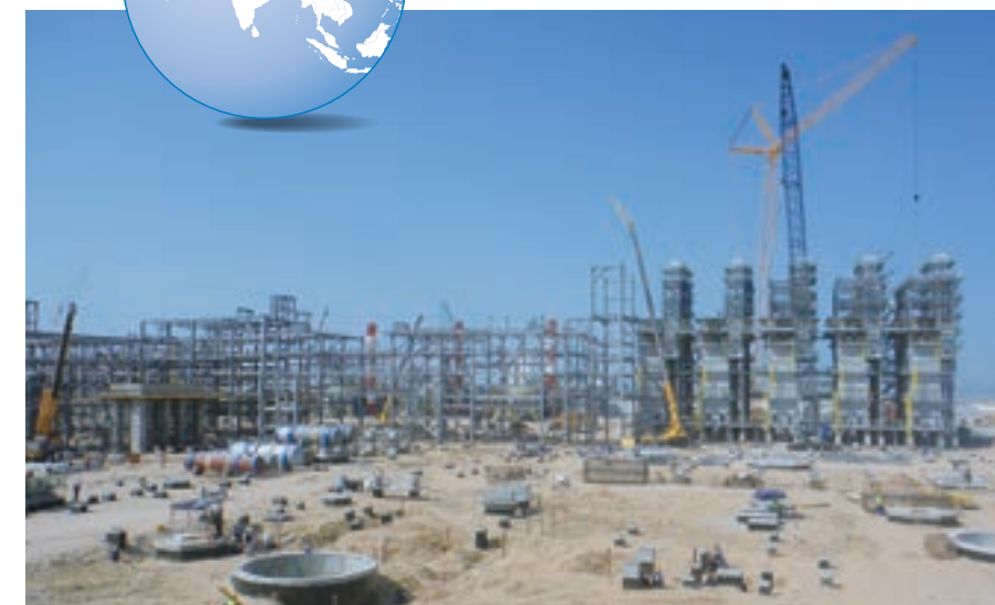
工事が進む現地
