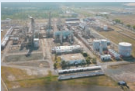
近代化が完了したガス処理プラント
