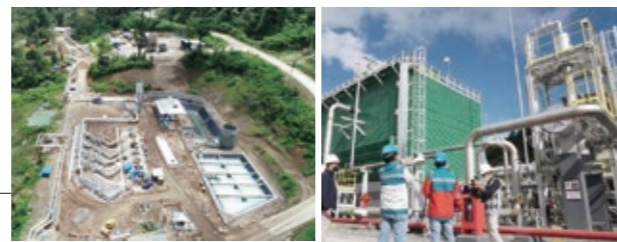
建設中のルムットバライ1号機地熱発電所 (55MW) ディエン小規模地熱発電所 (1×10MW)
