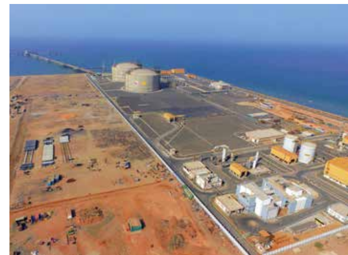
LNG Regasification Terminal, Mundra, Gujarat Client: GSPC LNG Limited
